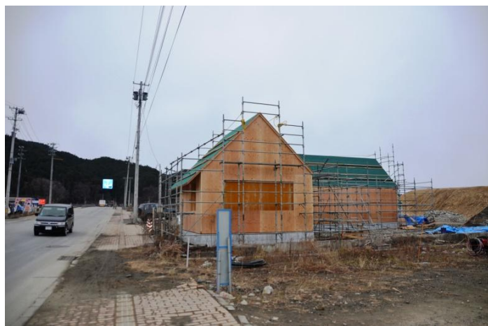
メディアセンターの本拠地として建設中のコミュニティプレイス。
