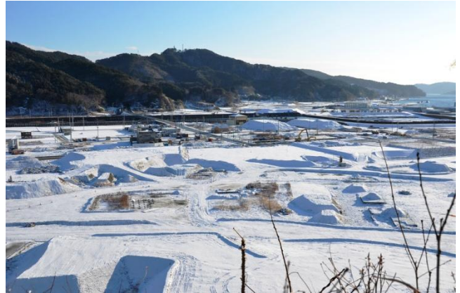
盛り土工事中に雪が降り地上絵のような市街地。
